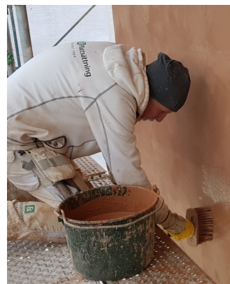
Mohammed Amini lägger puts och Lasse Wickberg avfärgar, dvs målar på med ny färg.
