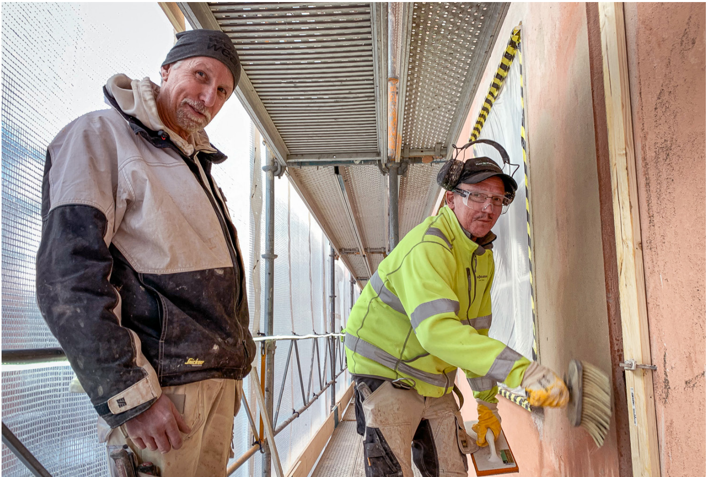
Murarna Lasse Wickberg och Jonny Pettersson gör fasaderna på Igeldammsgatan fina igen genom att lägga på puts och färg. "Utmaningen är att få belä fasaden att se ut som den gjorde innan", säger Lasse Wickberg.
