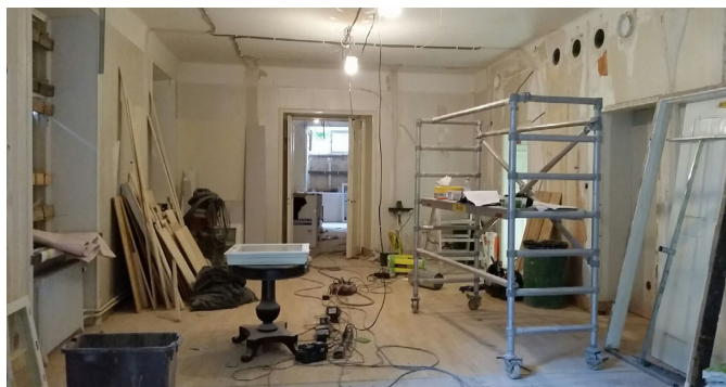
Innan. Salongen under renoveringen.
