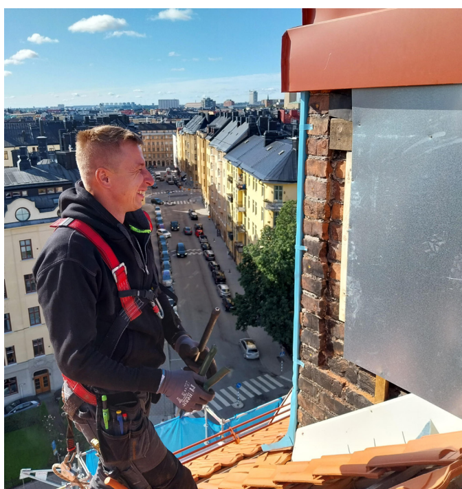
Skorstenarna kläs med ny plåt.
