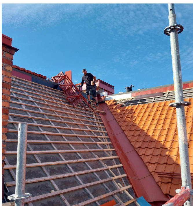
Taket får nytt tätskikt och nya takpannor.
