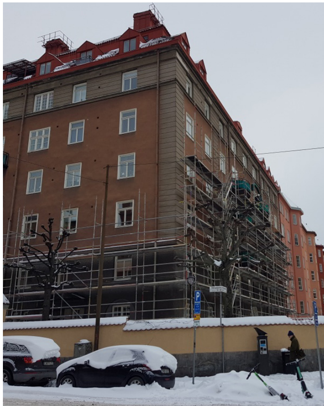
Fasaderna mot Vikingagatan och Karlbergsvägen är de mest väderutsatta.
